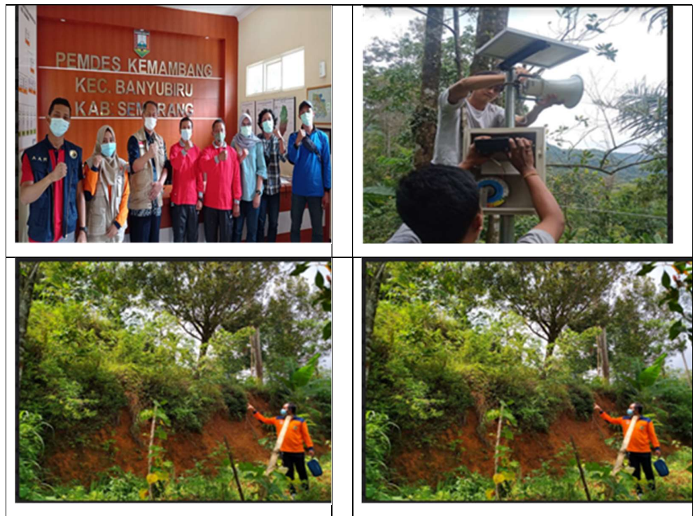
Gambar 9 Pemasangan Alat Sistem Peringatan Dini (EWS) tanah Longsor
