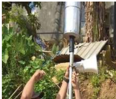
Gambar 13 Pemasangan Alat Sistim Pringatan Dini (EWS) tanah Longsor
